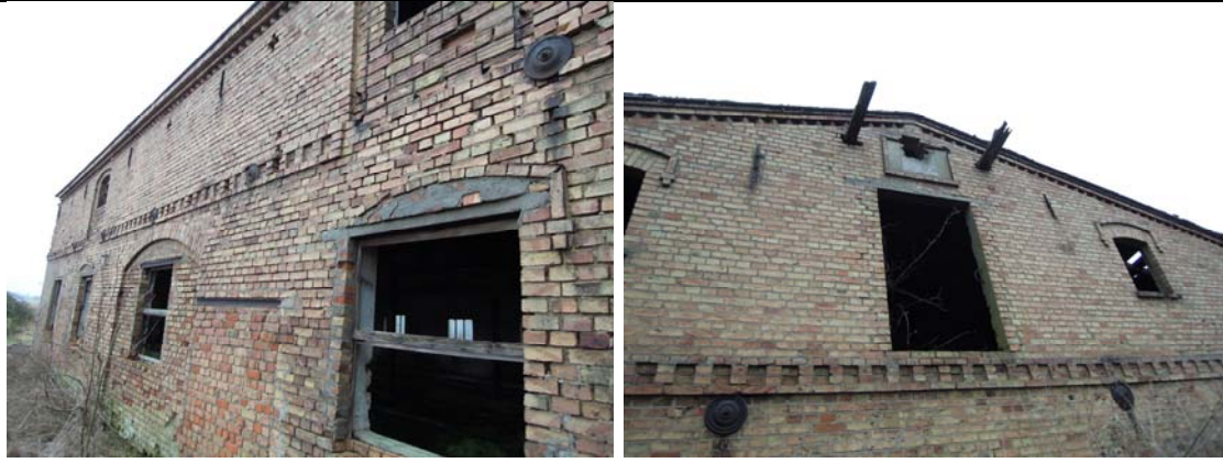
Maßnahme 9- Abb. 3: Abzureißendes Stallgebäude eigenes Foto 28.01.2015
