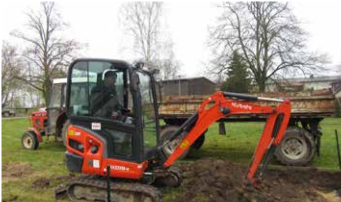
Einbauarbeiten einer Nestschaukel in Milow
