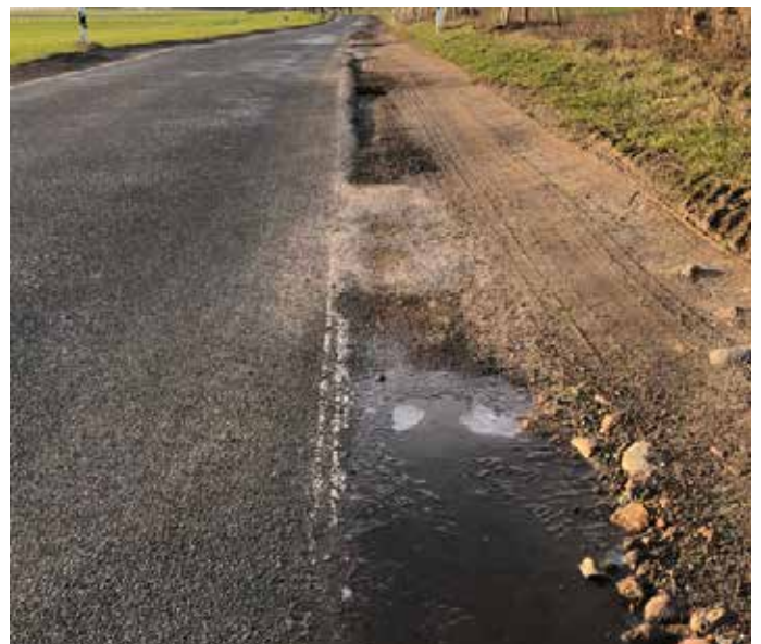
Straßenbaumaßnahme der L258 Bandelow/Trebenow
