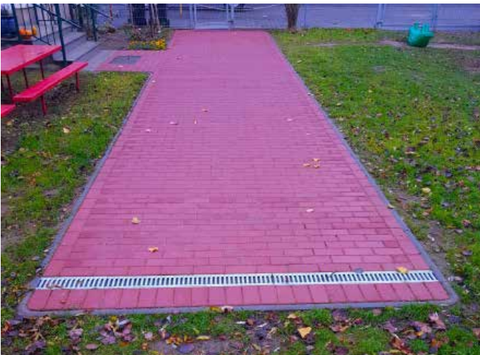
Regenwasserleitung und Weg in der Kita Jagow
