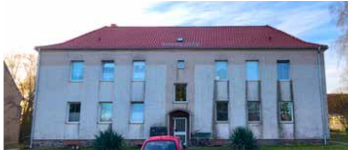
Dachsanierung Lübbenow Dorfstraße 14
