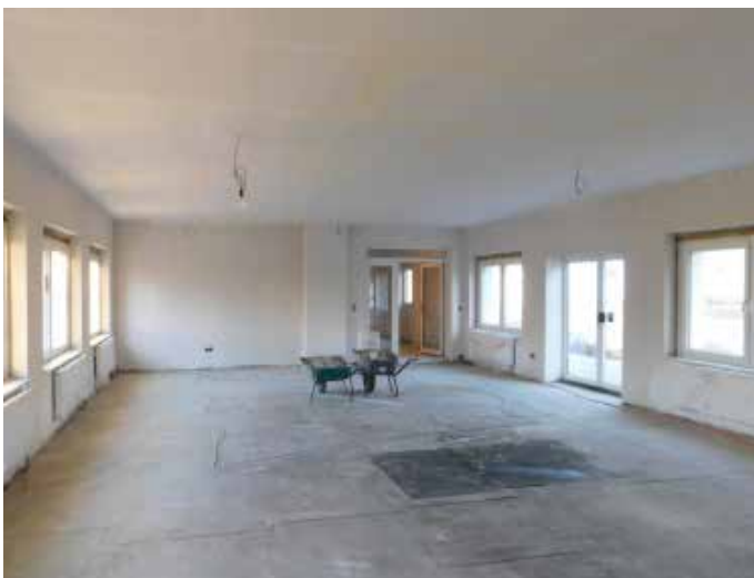
Innenausbau ehemalige Schulküche in Werbelow
