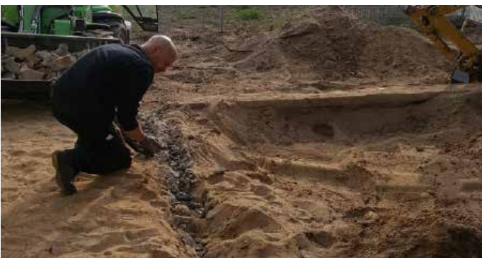
Pflasterarbeiten in der Kita Werbelow
