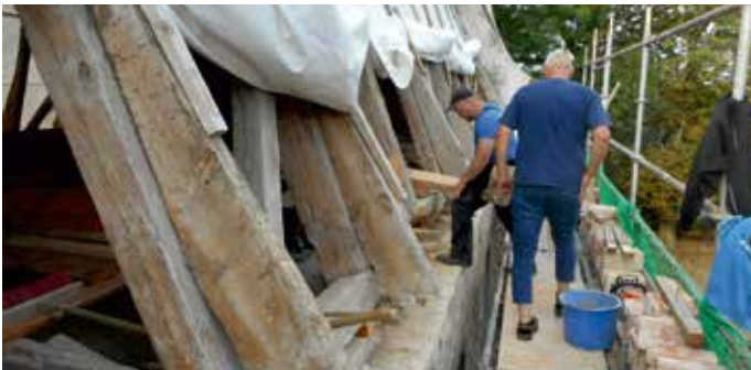
Ausführung von Maurer- und Zimmererarbeiten
