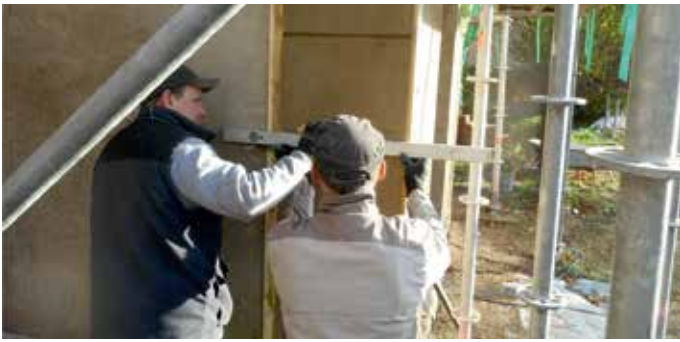
Putzarbeiten an der Vorhalle. Herstellung der Bossen.
