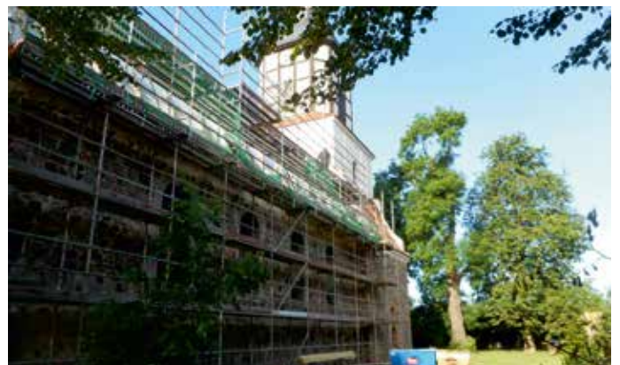
Nordansicht im Mai 2020
