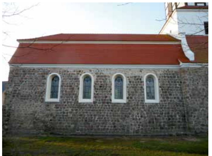
Nordansicht nach erfolgter Sanierung
