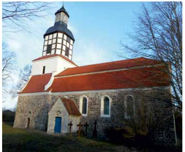
Nach der Sanierung: Ansicht von Süd
