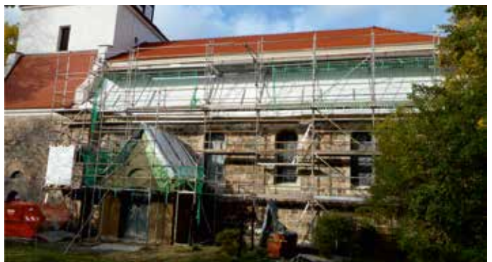
Ansicht Südseite Bautenstand im September 2020
