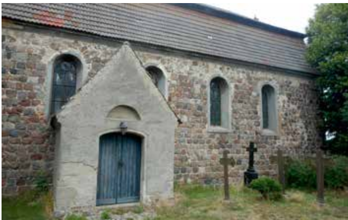
Südansicht mit Eingangshalle vor der Sanierung
