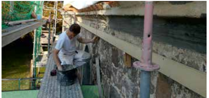
Vorbereitungen zur Ausführung der Stuckarbeiten an der Südseite
