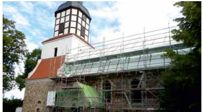
Ansicht Süd. Baubeginn Mai 2020 Fassadenrüstung, vorhandene Dacheindeckung wurde entfernt
