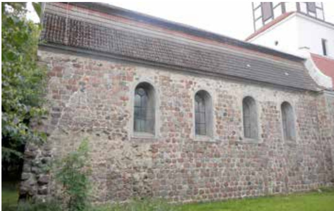
Kirchenschiff Nordansicht vor der Sanierung
