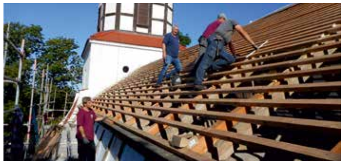
...während der Dachdeckungsarbeiten
