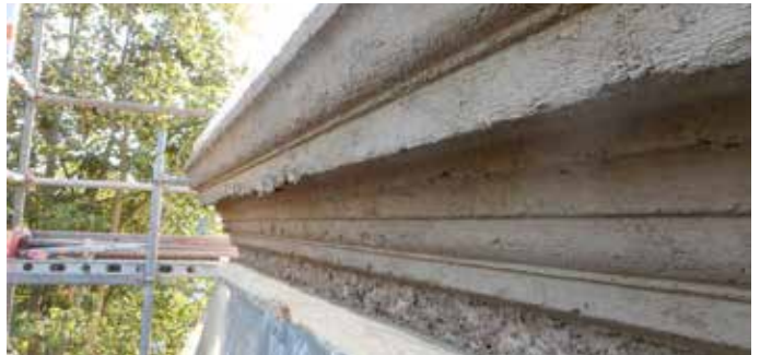
Fertiggestellter Grobzug Nordseite
