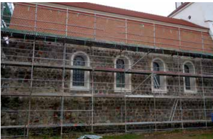
Nordseite November 2020 Die Verglasungen der Kirchenfenster sind fertiggestellt.
