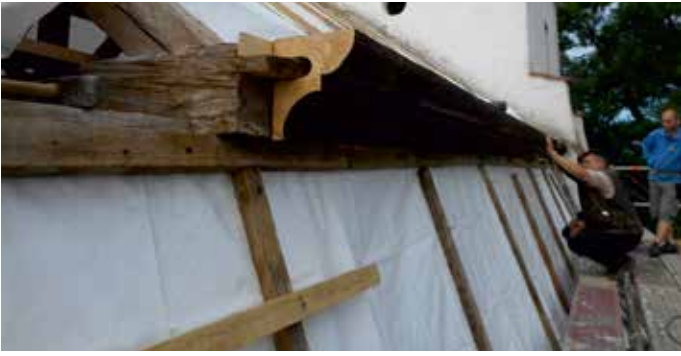
Während der Zimmererarbeiten am Mansardengesims Nordseite
