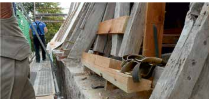
Das Traufgesims wurde aufgrund sehr starker Schädigungen teilweise erneuert.
