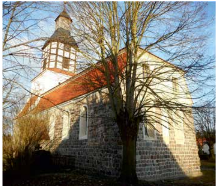
Ansicht von Süd-Ost
