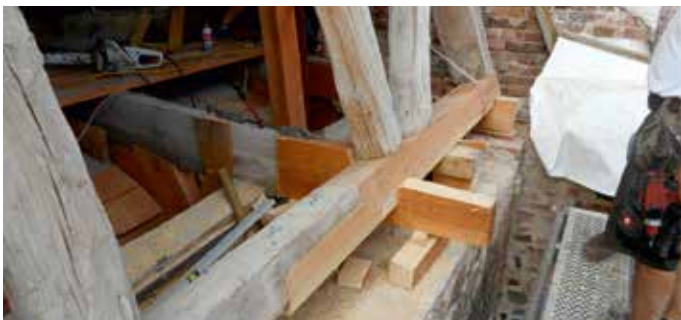
Sanierung der Mauerswellen und Balkenköpfe. Hier an der Nordseite im Anschlussbereich zum Turm Juni 2020
