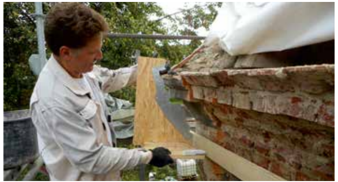
Zur Ausführung der Stuckarbeiten wurde das vorhandene Profil vom Bestand abgenommen und eine entsprechende Schablone angefertigt.
