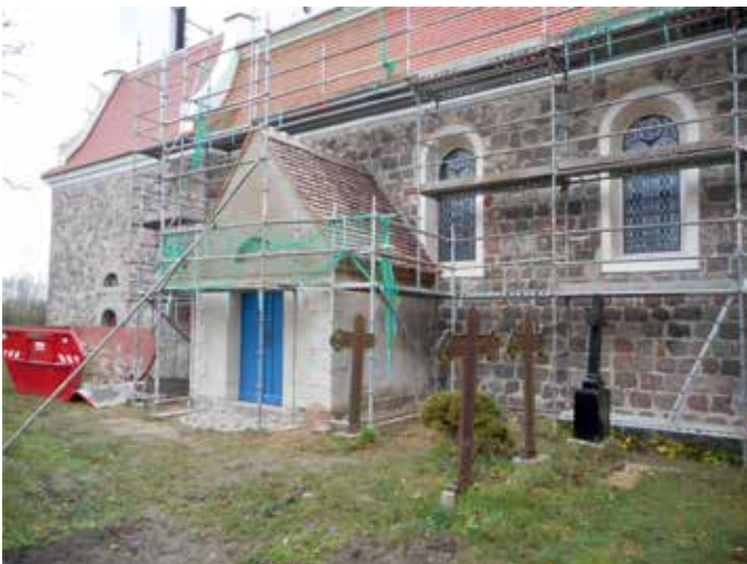
Die Dacheindeckung an der Vorhalle erfolgte mit den historischen Biberschwänzen. Die Reparatur der Kirchenfenster ist abgeschlossen.
