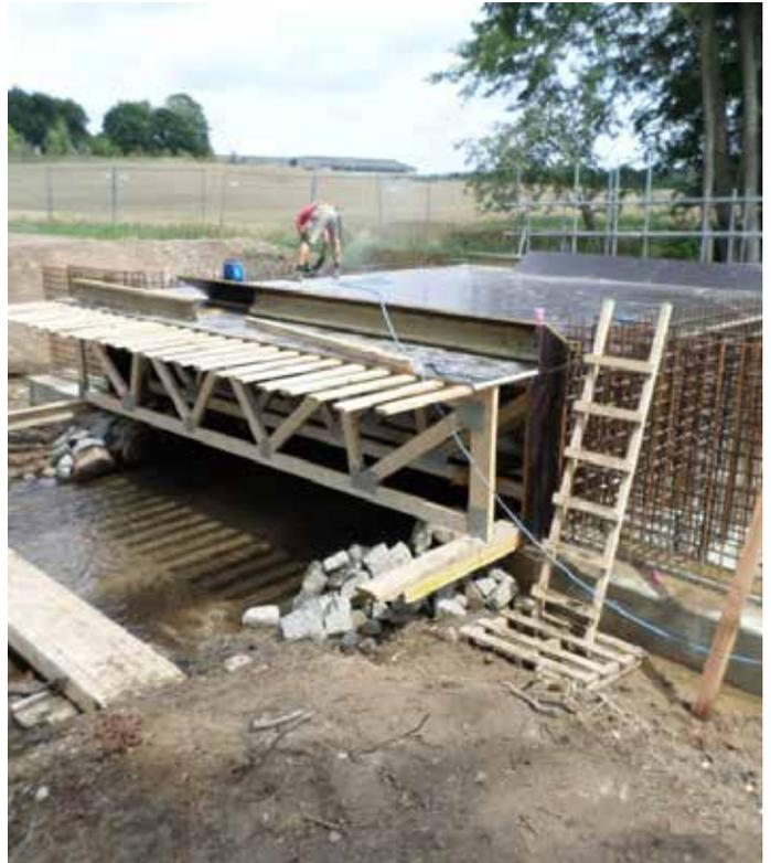
Im weiteren Verlauf sind Bewehrungs- und Schalungsarbeiten für den Brückenkörper durchgeführt worden, sodass Anfang August mit dem Betonieren dessen begonnen wurde.
