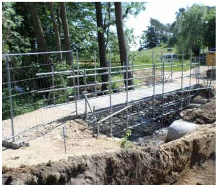
Für den fußläufigen Verkehr wurde über den Köhntop eine Behelfsbrücke errichtet. Somit ist der Rosenhof für die Kunden während der Bauzeit ständig erreichbar.
