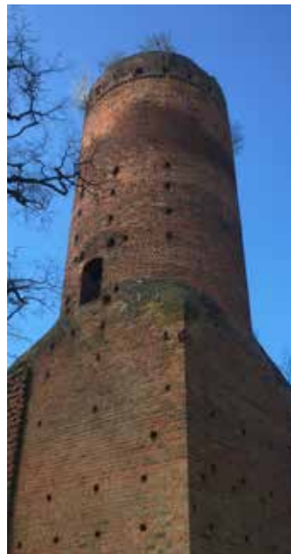
vor den Arbeiten
