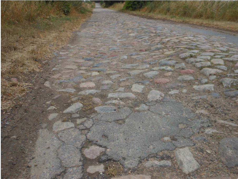
Maßnahme 25- Abb. 1: Detail Pflasterstraße zwischen Wolfshagen und Bandelow Eigenes Foto 11.07.2018
