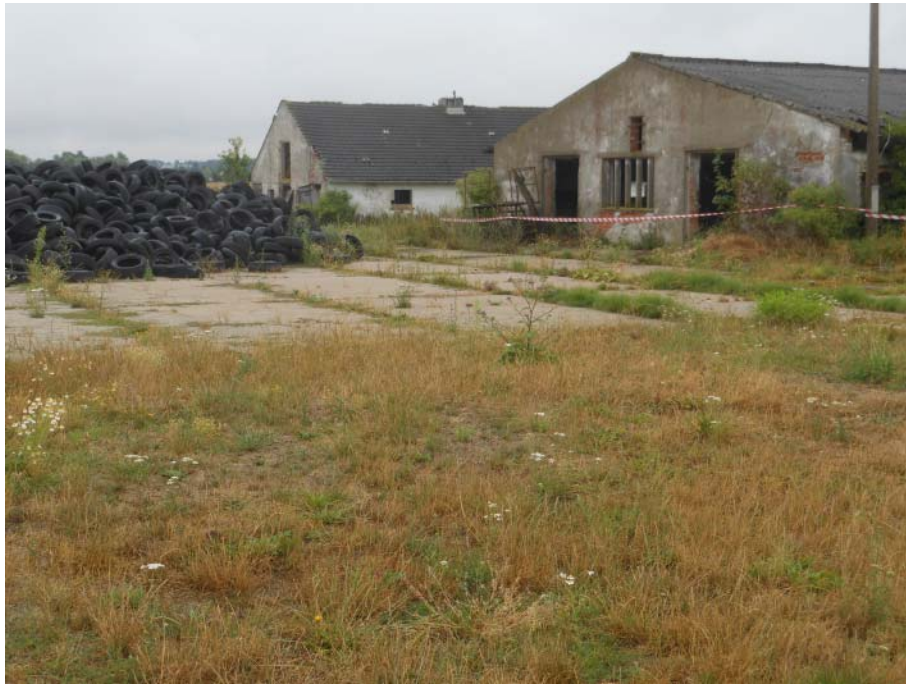
Maßnahme 19- Abb. 1: abzubrechende Stallgebäude mit Wegeflächen in Wilsickow Eigenes Foto 11.07.2018
