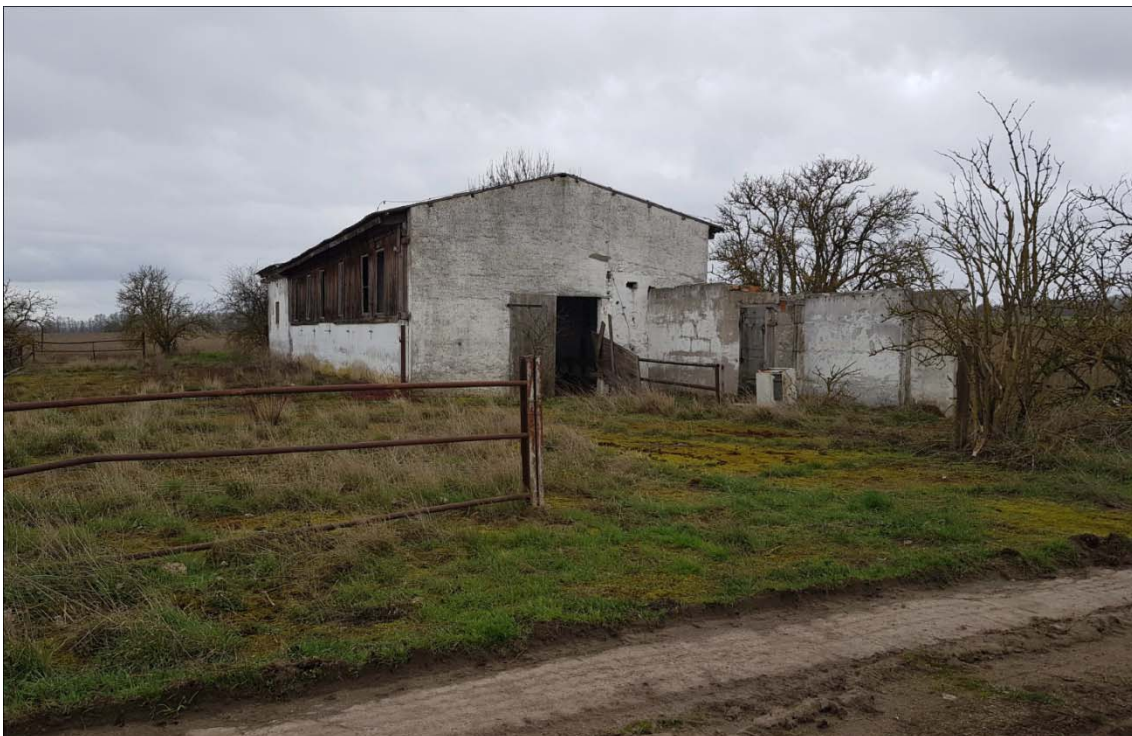
Maßnahme 26-Abb. 2: abzubrechender Melkstand mit Betonflächen am Weg von Trebenow in Richtung der Uckerwiesen
