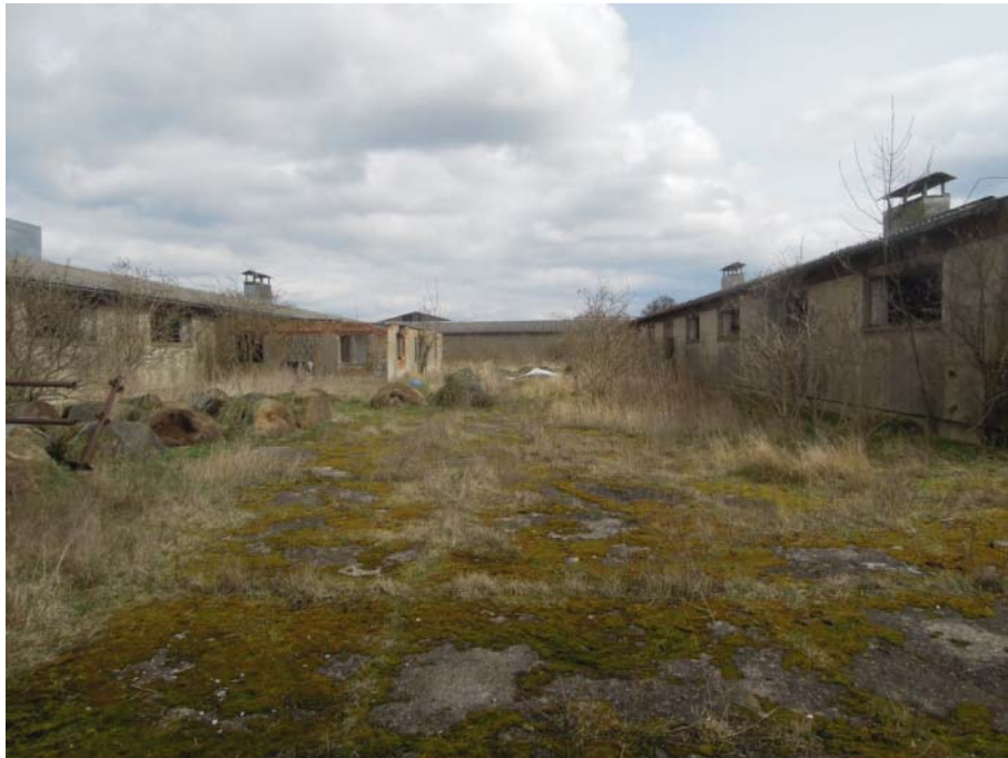
Maßnahme 4-Abb. 1: alte Stallanlage Jagow Eigenes Foto 31.03.2016
