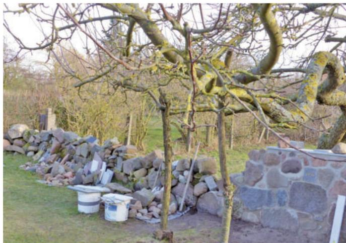
Im Herbst 2024 konnte die Arbeit abgeschlossen werden. Die Mauer hat eine Länge von 24,60 m, eine durchschnittliche Höhe von 1,40 m, eine Krone aus Granitplatten von 0,40 bis 0,46 m Breite und am Ende einen kleinen Turm von 0,88 m Höhe mit der Jahreszahl der Fertigstellung. Wertschätzung fand die damals noch im Aufbau befindliche Mauer u. a. im Sommer 2024 durch den RBB Brandenburg in der Sendung „Landschleicher Wilsickow“.
