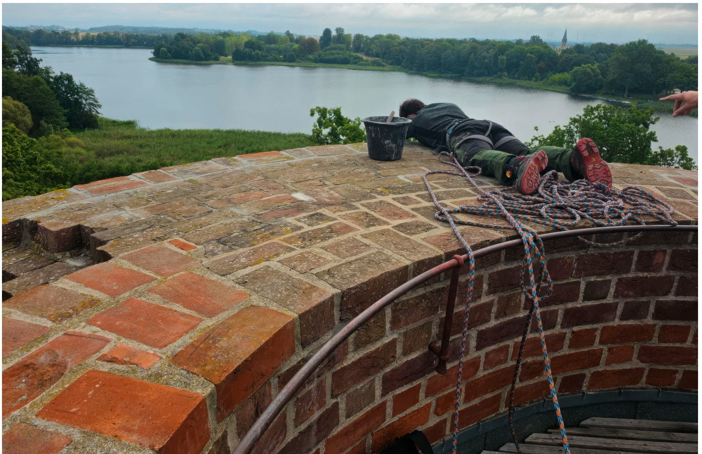
Reparatur der Mauerkrone in Wolfshagen
